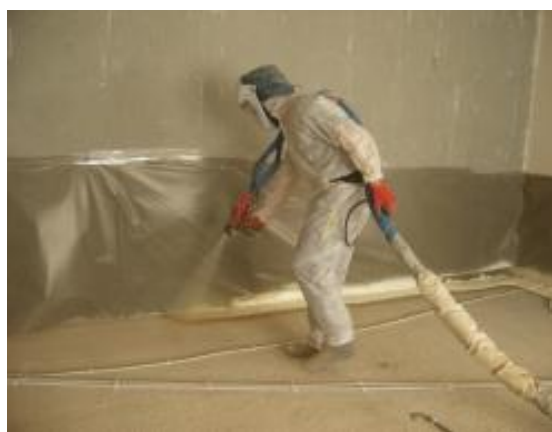
Isolation de sol.
